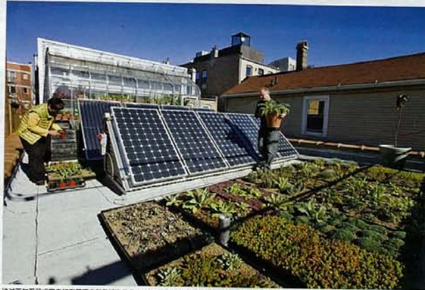
这对芝加哥艺术家夫妇在屋顶安装了转资昂贵的风能和太阳能发电系统，并种植植物吸收雨水
